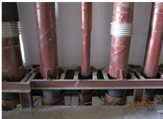
成排管道及支架安装
